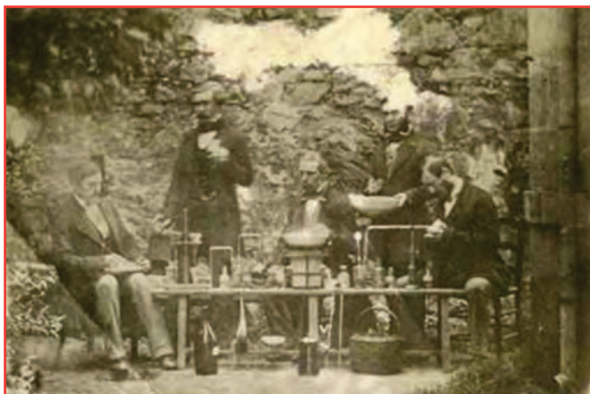
Figure 4 - Analyse de l'arsenic par l'appareil de Marsh (droite).
