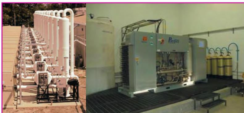
Figure 17 - Dispositif photocatalytique pilote Photo-Cat proposé par la société Purifics.
