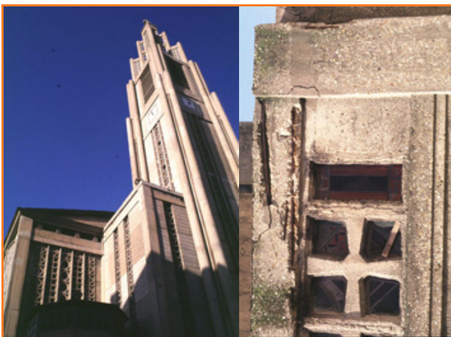
Le Raincy (93), église Notre-Dame, par Auguste Perret, 1922-1923, vue générale de la façade ouest et détail du béton altéré, avec des épaufrures laissant apparaître les armatures (© LRMH).
