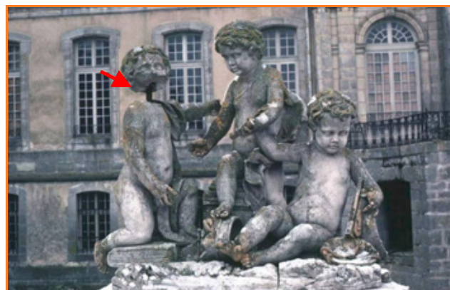
Figure 1 - Parc du château d'Haroué (Meurthe et Moselle) : exemple d'éléments métalliques oxydés rendus apparents par l'éclatement de la pierre.
