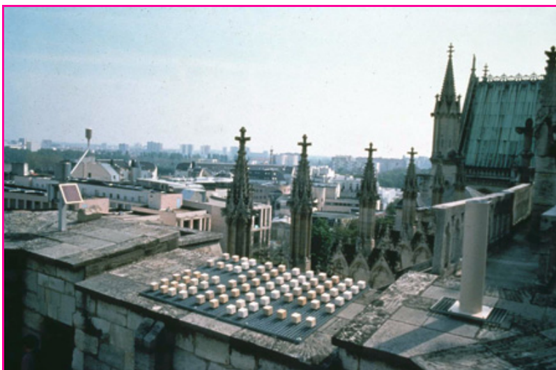
Exposition en partie haute de la cathédrale de Saint-Denis d'éprouvettes de pierre traitées et non traitées avec des produits hydrofuges, en vieillissement naturel (© LRMH).
