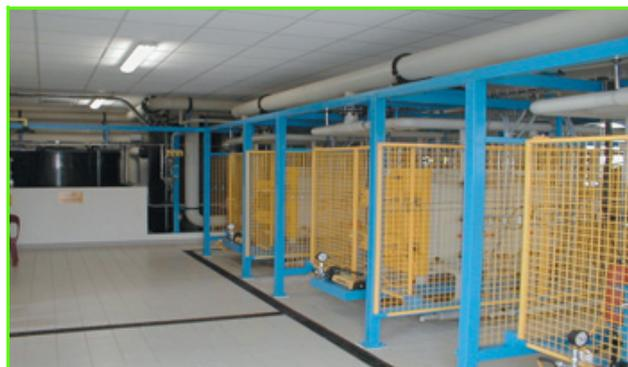
Figure 4 - Unité de dénitruration et adoucissement d'eau, 140 m<sup>3</sup>/h (réf. Eurodia).
