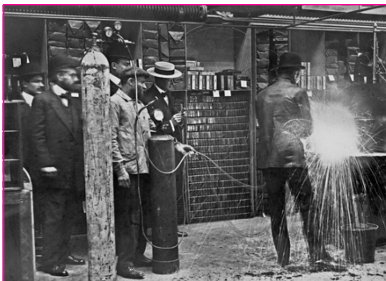
Figure 1 - Essai du chalumeau Fouché sur une paroi blindée, le 13 juin 1910. Le professeur Reiss, en canotier, observe les résultats. Ce sont les premières analyses des effets des chalumeaux à acétylène. © ESC Lausanne.
