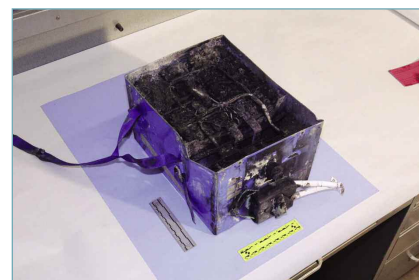
Une batterie incriminée (GS Yuasa Corp.).
