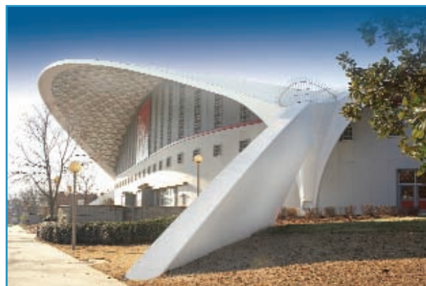
Toit en ciment de l'Université Stegeman Coliseum (Géorgie, États-Unis) revêtu de Kynar Aquatec®. © Arkema.
