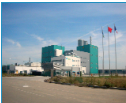
La nouvelle usine de silice haute performance située à Qingdao (© Rhodia).
