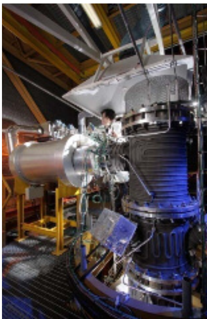
Installation PEGASE du centre CEA de Grenoble pour étudier les procédés de purification des gaz de synthèse. © P. Avavian/CEA.
