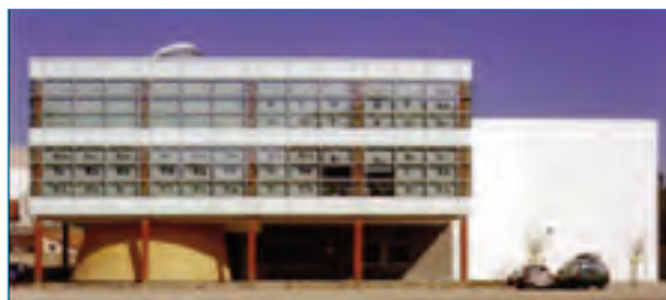
Le résultat des travaux (façade ouest). © Unanime Architectes/Photo Michel Folliet - Crocodile.
