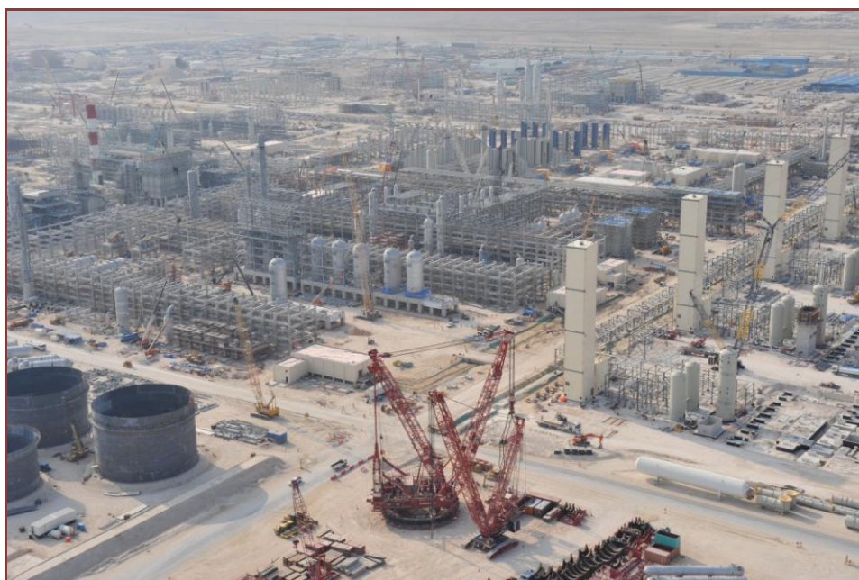
Vue aérienne site GTL Pearl en construction (février 2009). © Shell.
