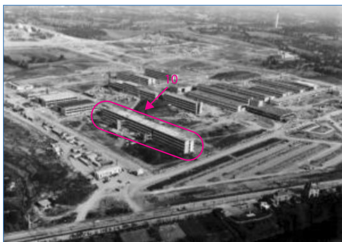
Figure 2 - Vue du campus de Beaulieu en construction, avec le long bâtiment 10 au premier plan.
